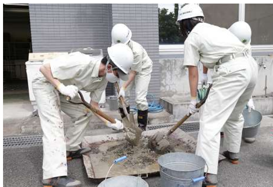
コンクリート実習
